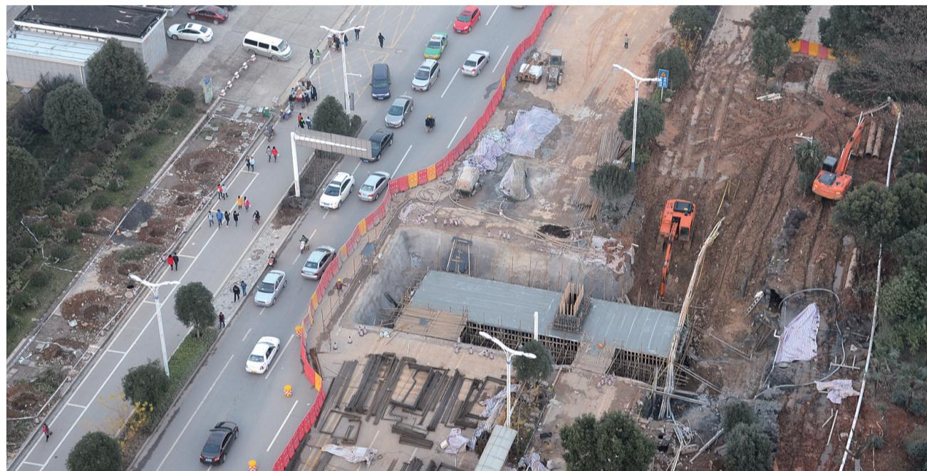
昨日,记者在咸宁大道我市首个地下人行通道施工现场看到,现场实行半幅封闭施工,一侧道路可见施工地下结构,钢筋混凝土箱涵主体已经形成。据了解,该地下主通道长69.5米,宽为5米,两端各设两个出口,计划明年投入使用。
