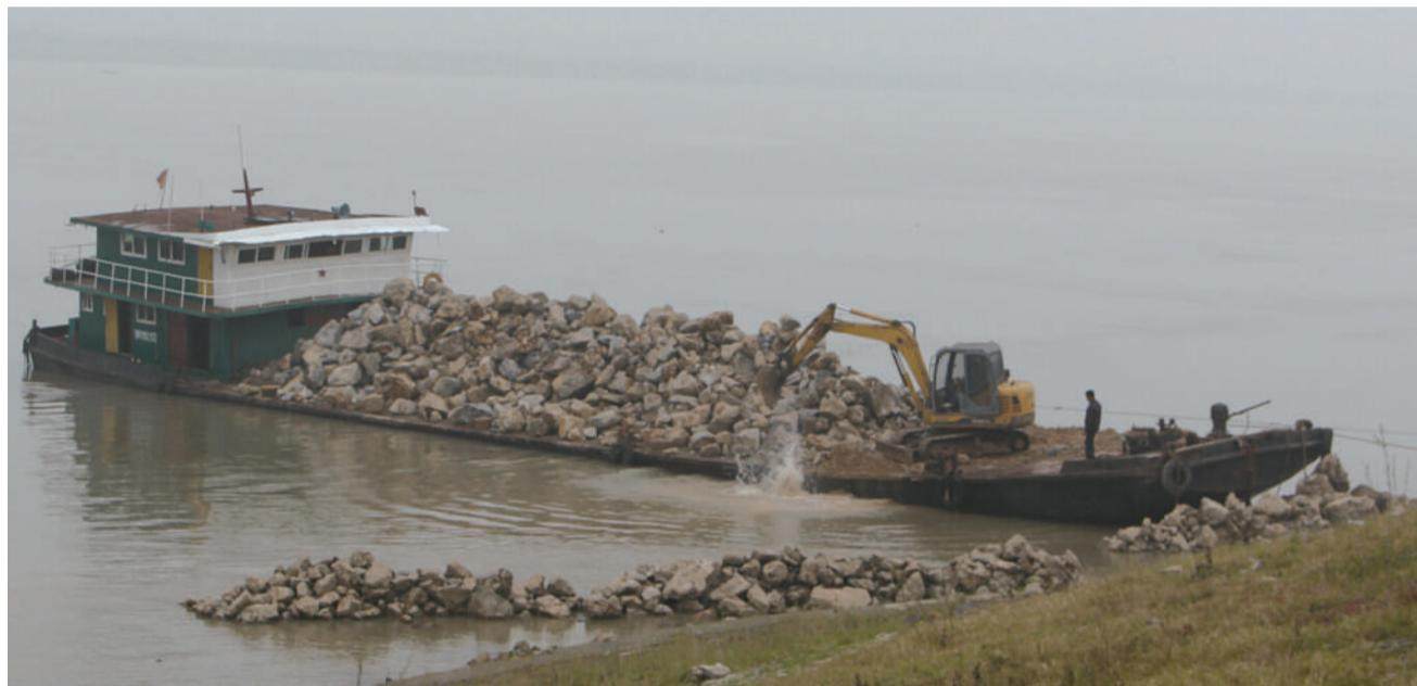
11月18日,在长江干堤嘉鱼县簰洲湾段河埠崩岸应急整治工程现场,两艘装满石料的轮船上,工程机械正进行抛石作业。据悉,河埠崩岸应急整治工程位于簰洲湾大堤14+200米至14+400米处,该项目主要工程量为水下抛石4050方、岸坡修复等。11月8日,施工方开始进行抛石作业,目前共抛石2004方,计划还将抛石2000方。待水位退至抛石枯水平台以下时,将对抛石坡度及厚度进行调整,同时进行岸坡整修,计划在12月底完工。
