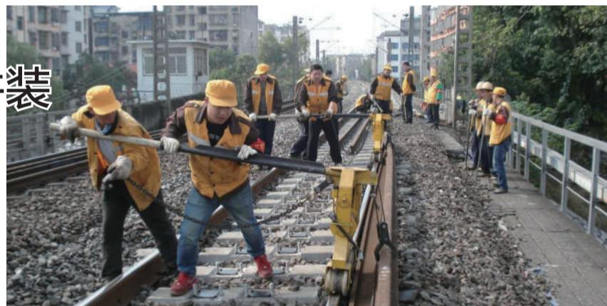
京广铁路上行线蒲圻至赤壁区段近期进行集中修机械换枕施工后,11月10日至12日,武汉桥工段蒲圻线路工区职工使用新型的多功能拉运轨机,经过三天连续奋战,将赤壁市陆水河上的京广线蒲圻铁路大桥双股740米长桥梁护轨拼装并紧固到位,为大桥稳固夯实了基础。
