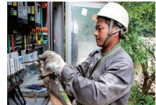
7月15日,崇阳县供电公司员工顶着38℃高温为肖岭乡金不村4组安装智能配电柜。邓东峰/摄
