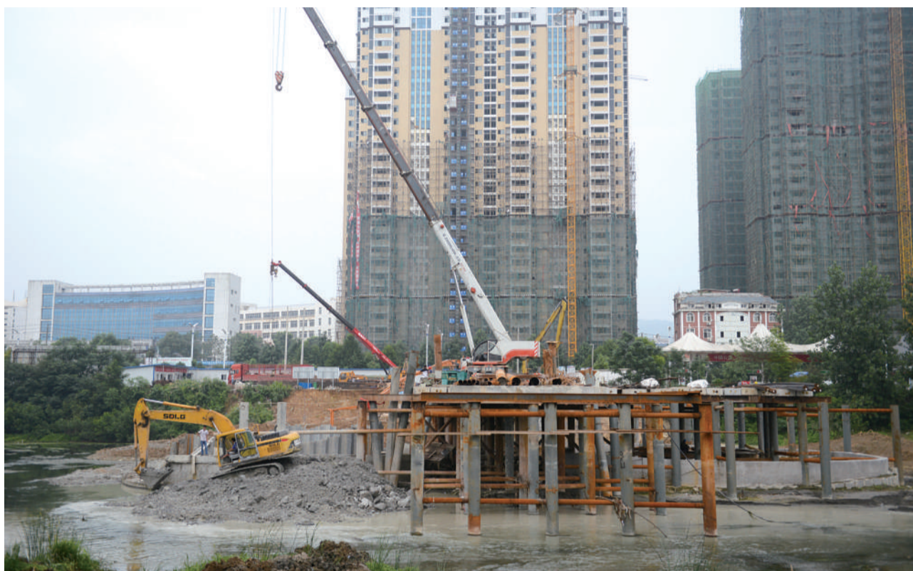
19日,记者在淦河大桥施工现场看到,工程的打桩工序已经完工。据悉,淦河大桥南起咸宁大道龙潭加油站处,跨越淦河后北行直抵城铁南站,桥梁设计全长144米,宽25米,双向四车道,通车后城铁南站区域交通将更加畅通。 赵忠志/摄
