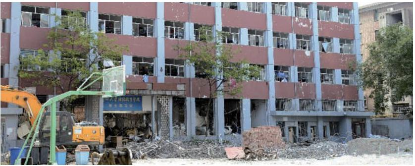
**新华网消息** 20日下午,兰州市城关区委宣传部通报,20日7时32分,兰州大学医学校区南校区院内,发生一起气体爆燃事故。经核实,事故造成31人受伤,目前还有28人留院观察(其中兰大医学院学生23人,外校来访学生1人,军区四所1人,施工单位3人,均为男性)。据通报,事故原因已初步查明,系施工方在实施拆除作业过程中,损坏了已封堵的钢质燃气管道,造成天然气泄漏导致爆燃。
