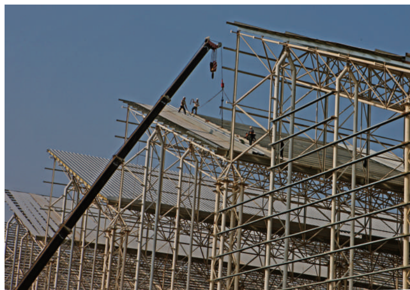
在建的咸宁祥天自然能发电空气储能厂房一角。
