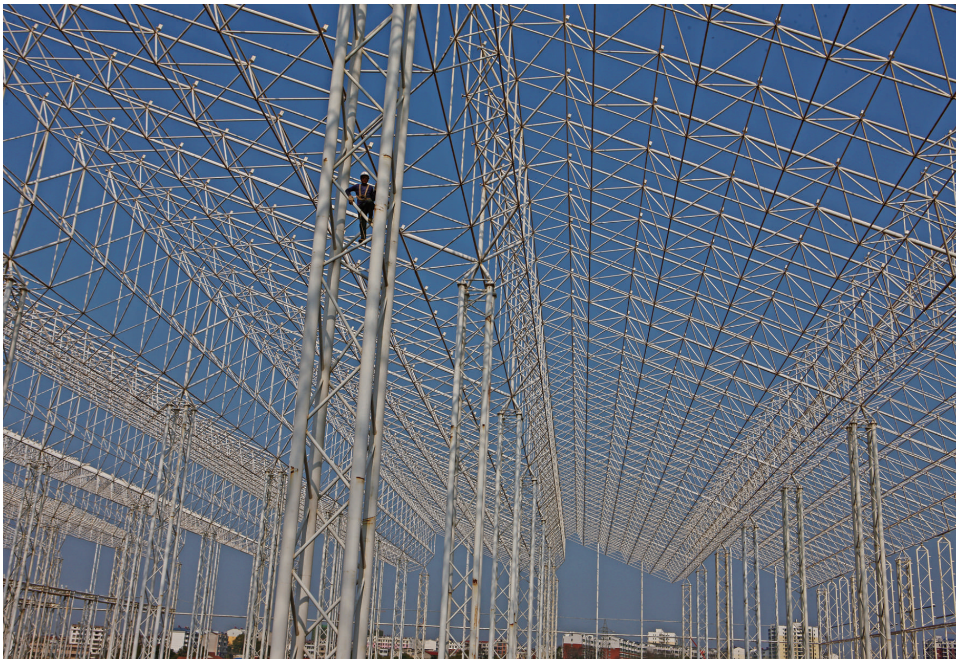
在建的咸宁祥天自然能发电空气储能厂房。
