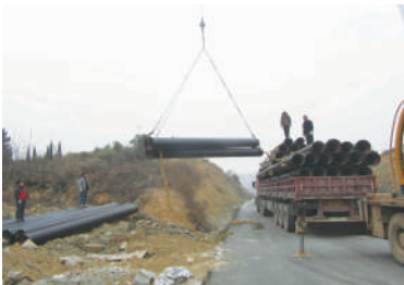
咸潘一级路DN400供水施工现场
