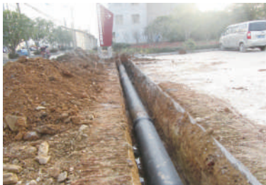
龙潭大道DN400供水施工现场
