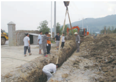
旅游集散中心施工现场
