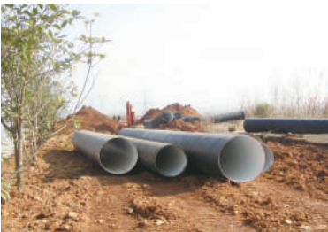
南外环DN800供水施工现场
