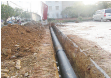
龙潭大道DN400供水施工现场
