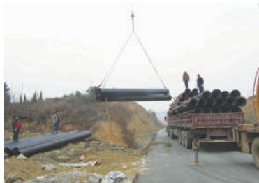
咸潘一级路DN400供水施工现场
