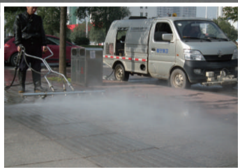
中联ZLJ5020TYHE4型路面养护车正在冲洗人行道
