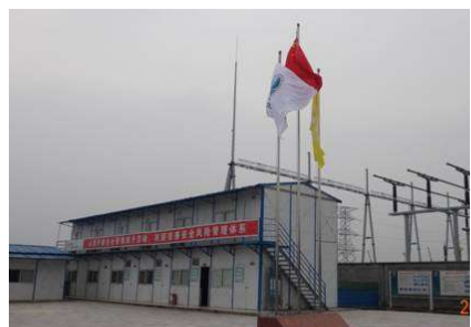
220kV通城变现场安全文明施工标准化管理
