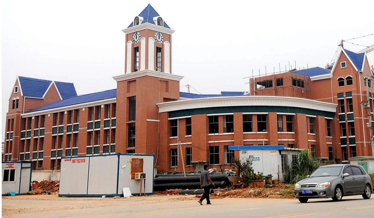
近日,记者在市区书台街与十六潭路交汇处看到,一座欧式风格的建筑——咸宁市实验外国语学校竣工在即。目前,工人正在紧张地进行室内装修和基础设施建设。据悉,该项目总投资1.8亿元,总建筑面积约5万平方米,9月份正式开学。 方达星/摄
