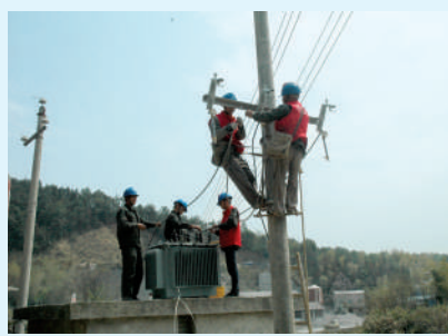
更换老化的变压器
