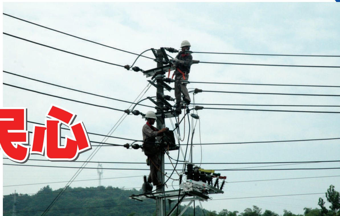
对官塘10千伏高压线维护检修
