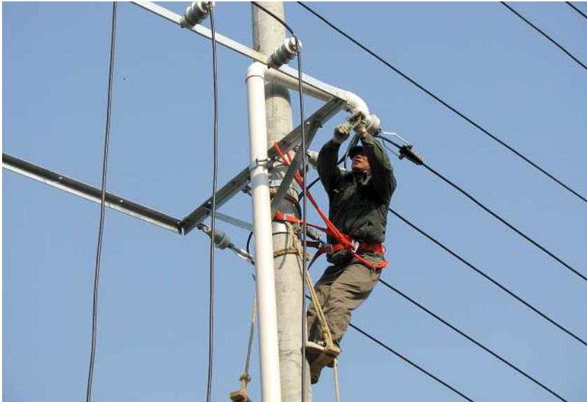
为了让村民在春节来临之前能够用上“放心电”,通山县供电公司明水供电所在半个月时间里,为通羊镇岭下村新增50kVA配变一台,新架设12米水泥杆5基,新建380V线路872米,解决了该村低压难题。 华凤平 宋绍东/摄
