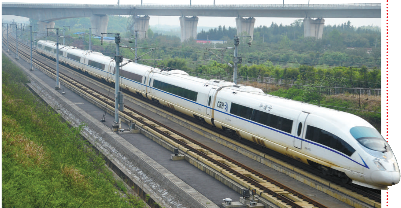
武咸城际铁路跨武广高铁特大桥下,一列动车飞驰而过。
