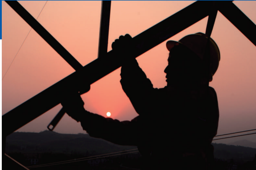
国网咸宁供电公司员工顶着落日奋战在铁塔上。
