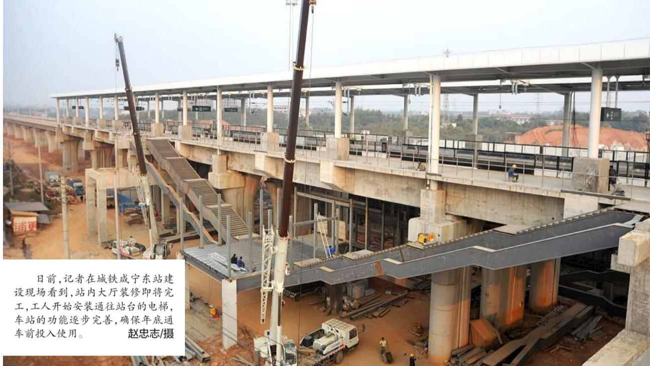
日前,记者在城铁咸宁东站建设现场看到,站内大厅装修即将完工,工人开始安装通往站台的电梯,车站的功能逐步完善,确保年底通车前投入使用。
