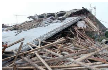
高速公路,4名受伤工人分别来自贵州和湖北。目前,事故原因正在调查中。
