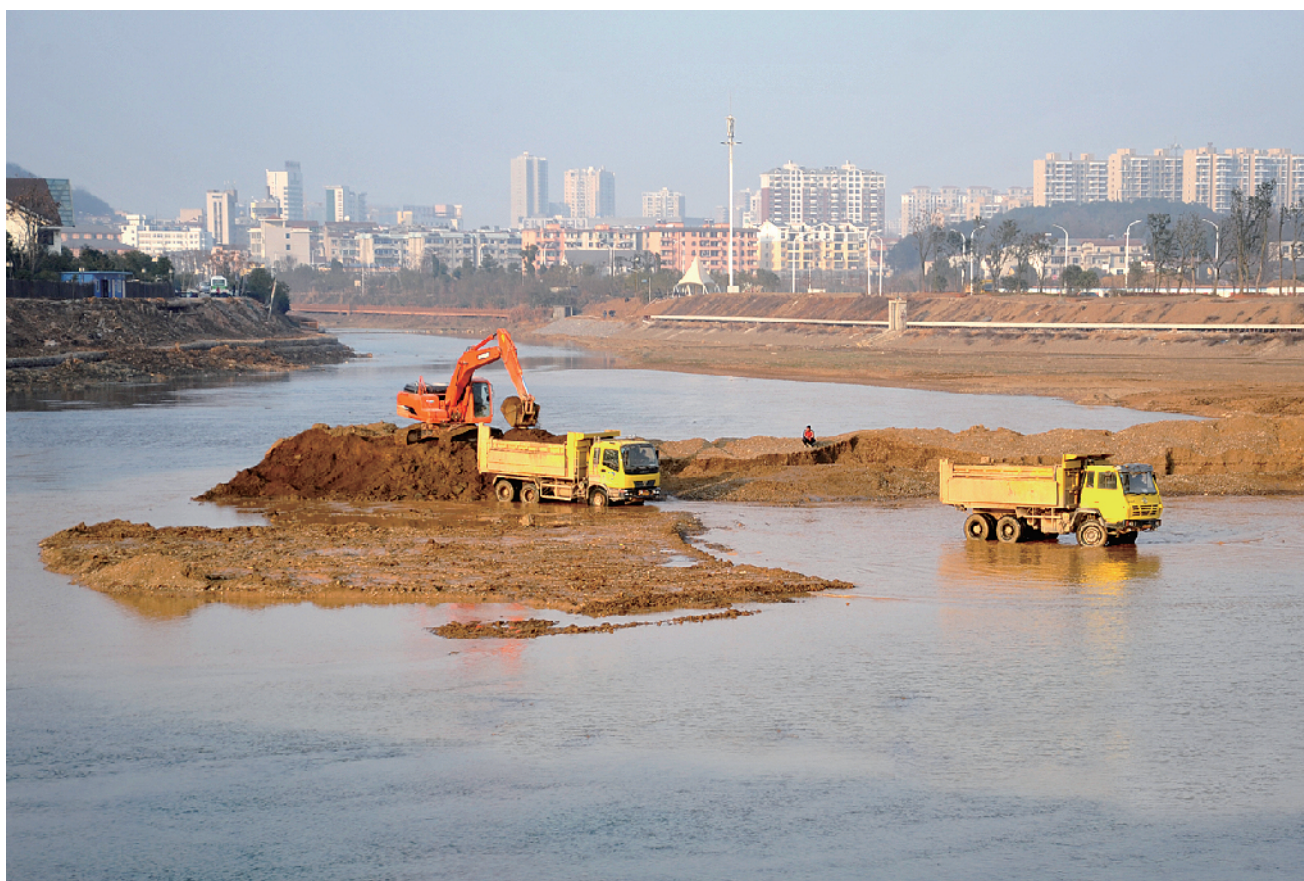
13日,记者在咸宁温泉旅游生态新城南入口综合服务区看到,建设现场一派繁忙。温泉人工湖项目初现雏形,旅游集散中心也在紧张施工,各项配套工程均按规划稳步推进。
