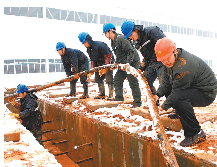
2012年12月26日,咸宁供电公司员工在雪中为南玻玻璃有限公司铺设供电电缆。 邓东峰摄
