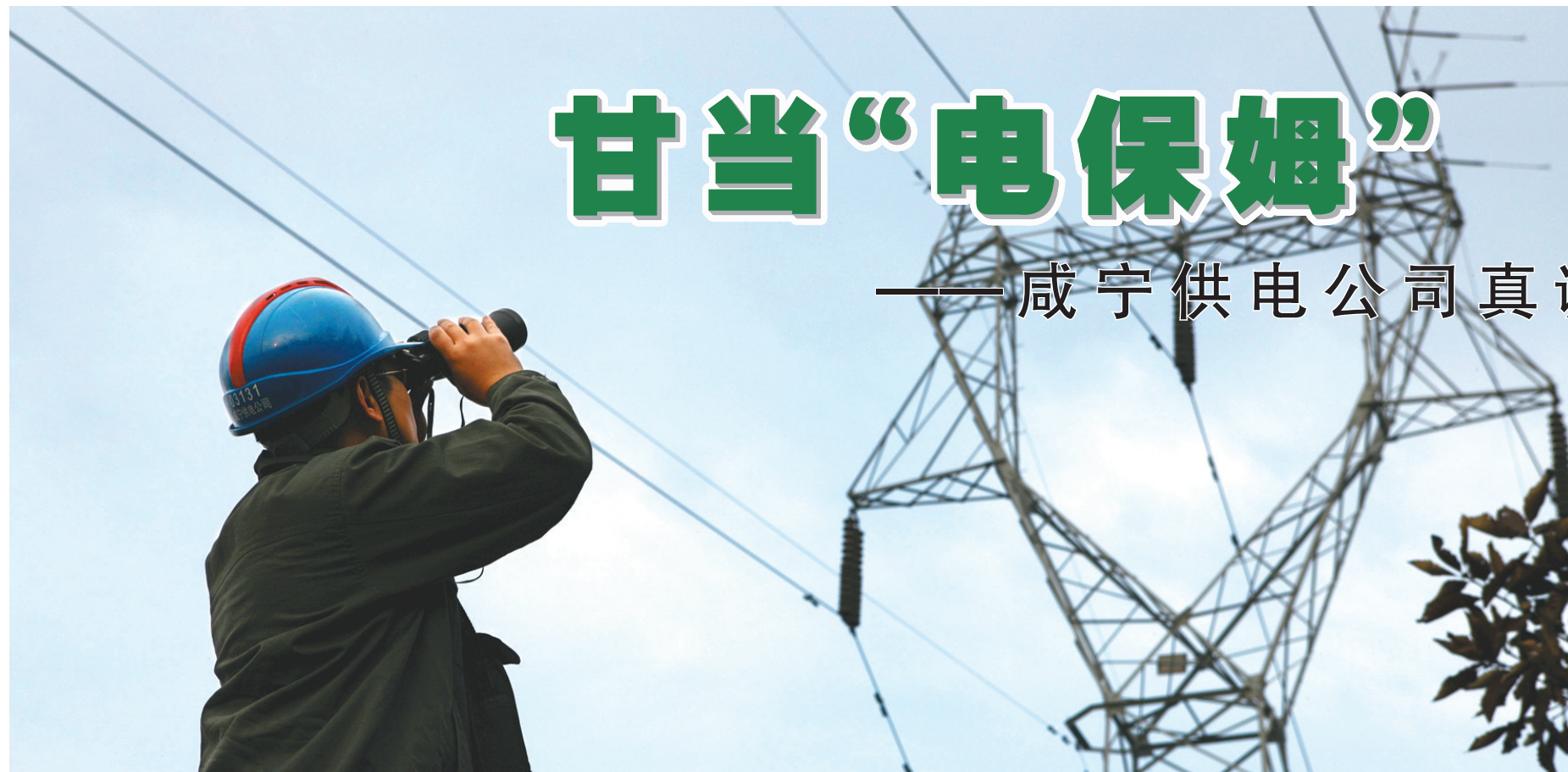
2012年12月6日,咸宁供电公司检修公司员工在巡查220千伏塘汪线。 邓东峰摄
